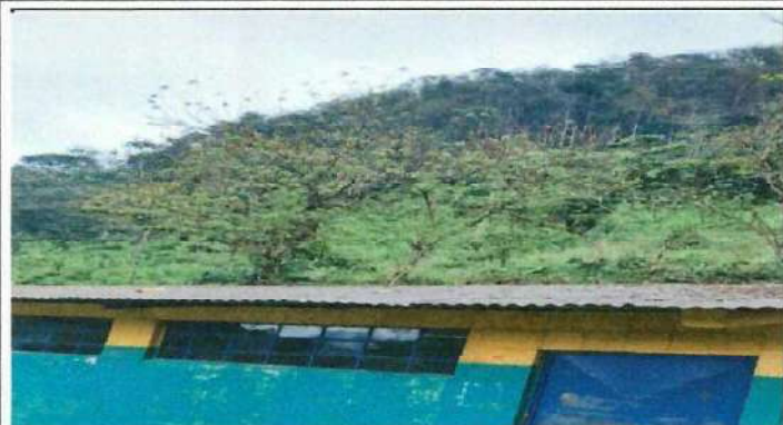
Foto1: SUSTITUCION DE LAMINAS EN AULAS
