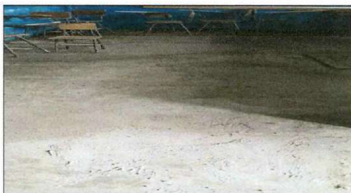
Foto 4: SUSTITUCION DE PISO
