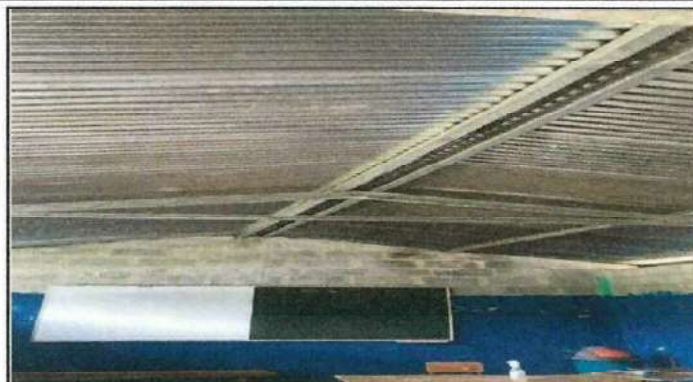
Foto 2: SUSTITUCION DE COSTANERAS
