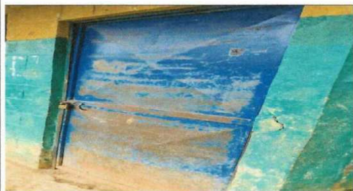
Foto 3: SUSTITUCION DE PUERTAS DE METAL EN MAL ESTADO
